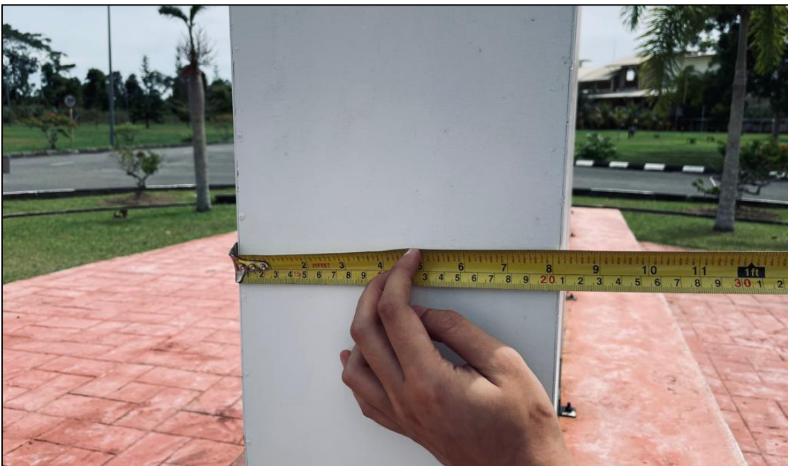
Rajah 5.11 : Kerja Pengukuran pada Tiang
